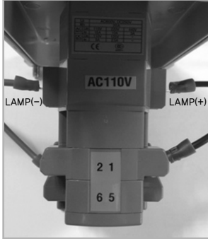
(1) LAMP 극성 확인 후 결선 및 회로에 따라 배선 (Wiring by circuit after check LAMP polarity.)
